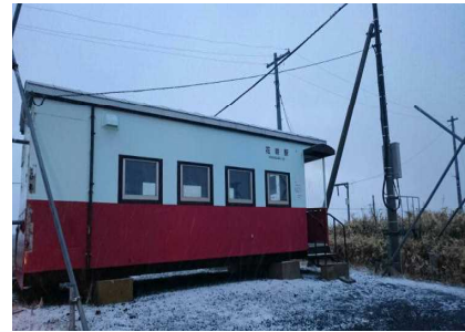
廃止になった花咲線の花咲駅舎
