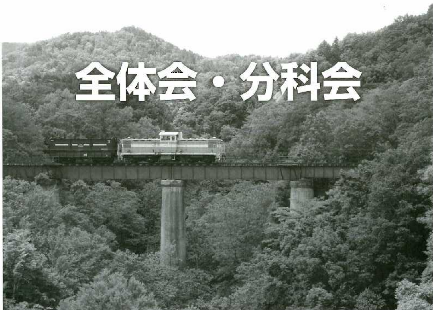
芦別市 旧三井芦別鉄道炭山橋橋梁
